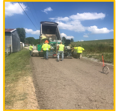
Grannas Brothers laying the DSA.
